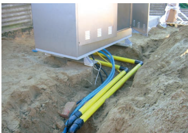
Facilità di installazione delle tubazioni acqua e gas e kit di riduzione Easy installation of water and gas pipes and reduction unit
