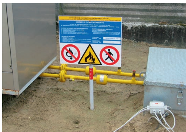
Facilità di installazione delle tubazioni fase liquida e gassosa Easy installation of gas and liquid phase pipes
